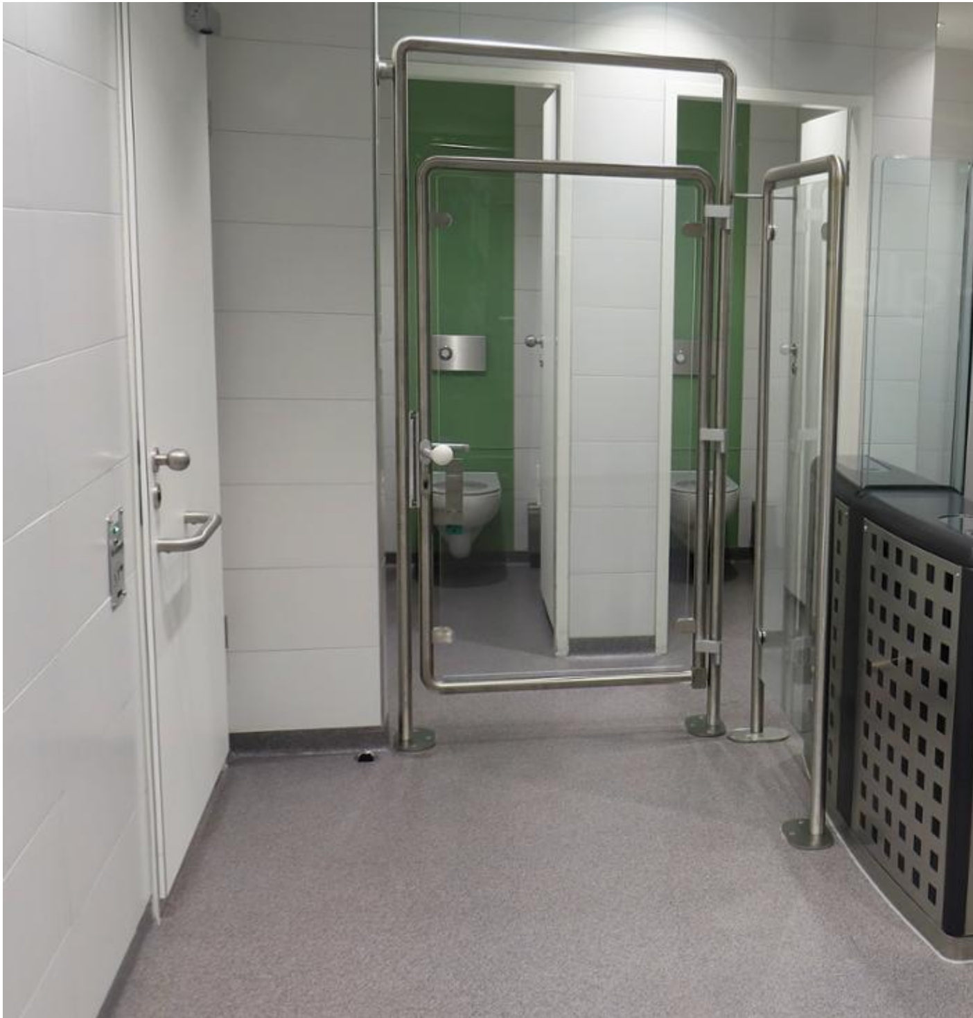
So schaut der Eingang der sanierten Toilettenanlage an der U-Bahn Fraunhoferstraße aus © Markus Götzfried
